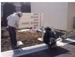
敷地内誘導サイン施工中
