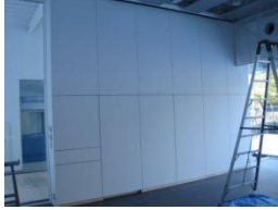
天井・柱との納まり写真
