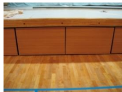
ステージ下飾り板シート交換
