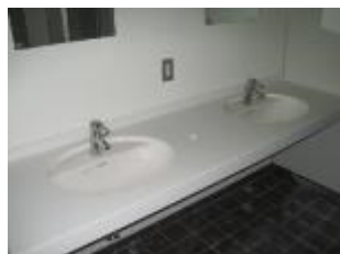
洗面カウンター
