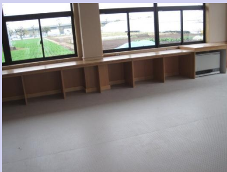
作業台・空調機収納庫設置完了
