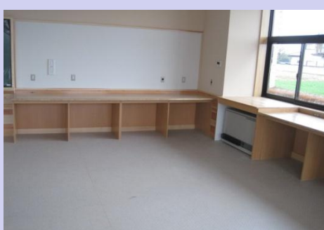
作業台・空調機収納庫設置完了
