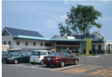
改修前正面玄関外観
